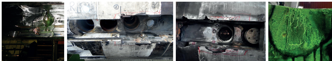
Rys. 2. Wirnik generatora typu TWW-1000-2Y3 – przykłady powstałych uszkodzeń na skutek zajarzenia łuku elektrycznego
